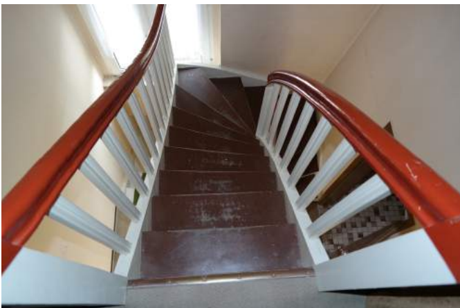
Treppe zur Mansarde
