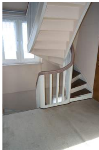
Treppe zur Mansarde
